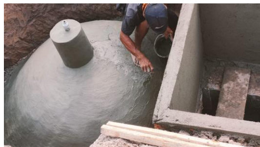
Gambar 3. Tempat penampungan biogas sebagai contoh teknologi tepat guna. Sumber: Dokumentasi kegiatan PKM, 2024.
